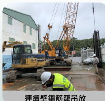
連續壁鋼筋籠吊放
