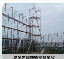
現場連續壁鋼筋籠吊放
