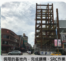
侷限的基地內，完成鋼構、SRC作業
