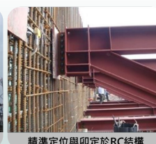
精準定位與卯定於RC結構
