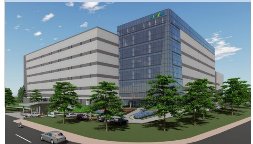
緯穎南科二廠新建工程
