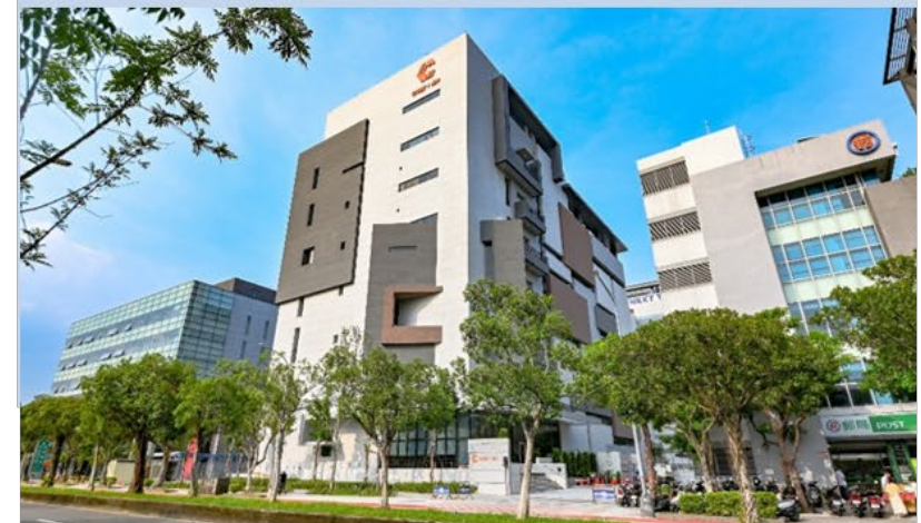
是方電訊 IDC機房新建工程
