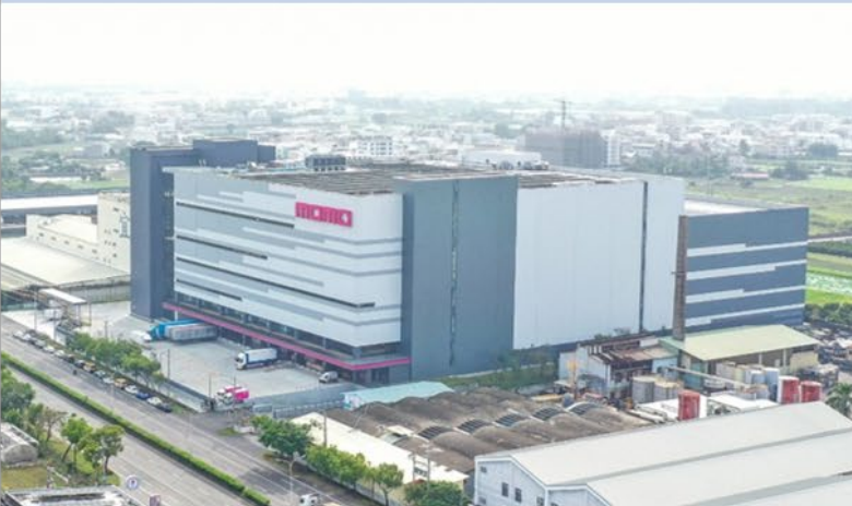
momo 南區儲配運輸物流中心新建工程
