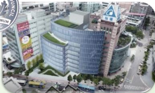
台達電子內湖總部 瑞光大樓增建工程 LEED 白金級認證
